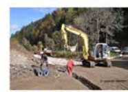
RECONSTRUCTION VOIE LA CLUZE-LES HÔPITAL NEUFS (26)
