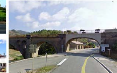
VIADUC DE CAMON (71)
