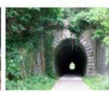
TUNNEL DE SAMPIGNY (71) AVANT - APRÈS
